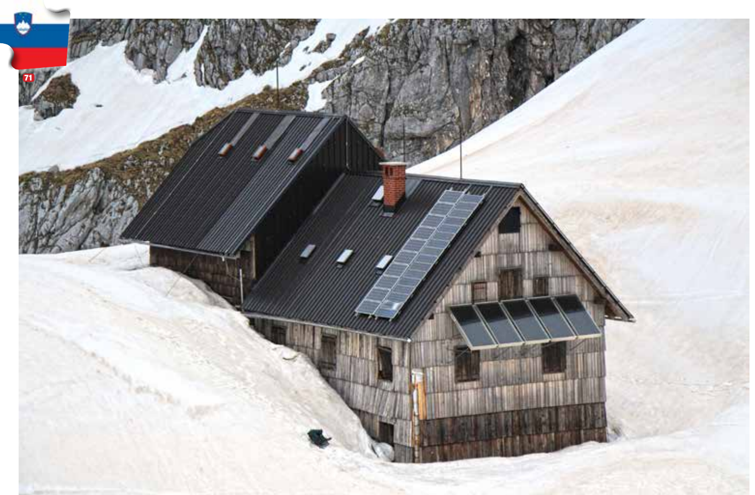
71 Beschädigte Dolič-Hütte. (Foto: Miha Pavšek) |
