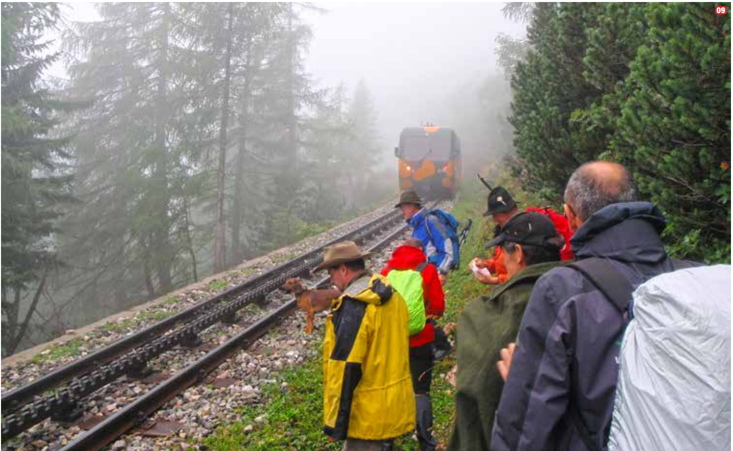
09 Während der Begehung (bzw. „Befahrung“) wurden die lawinengefährdeten Bereiche genau unter die Lupe genommen. (Foto: LWD Niederösterreich) |
