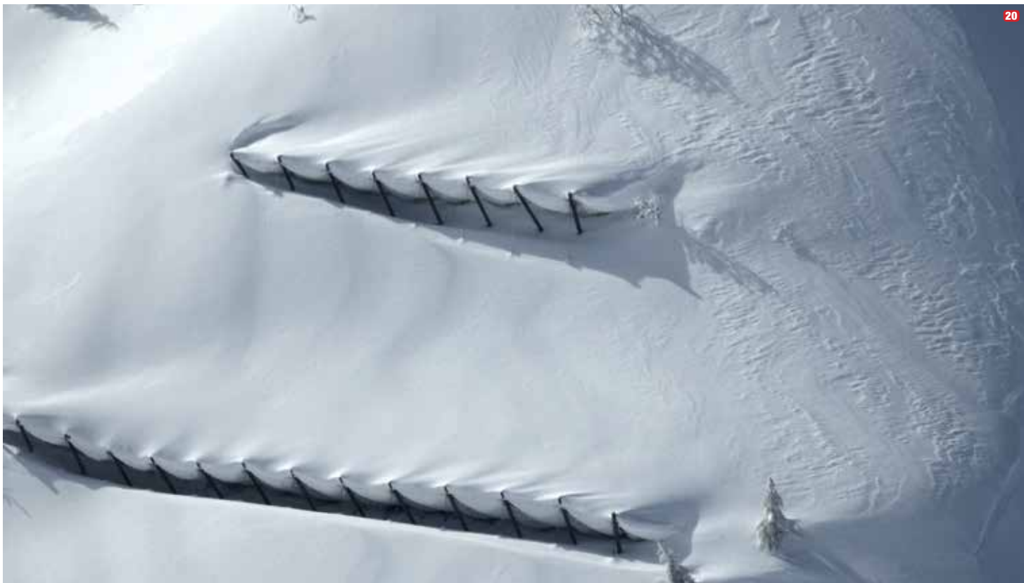
20 Gut befüllte Lawinerverbauungen. (Foto: LWD Kärnten) |
