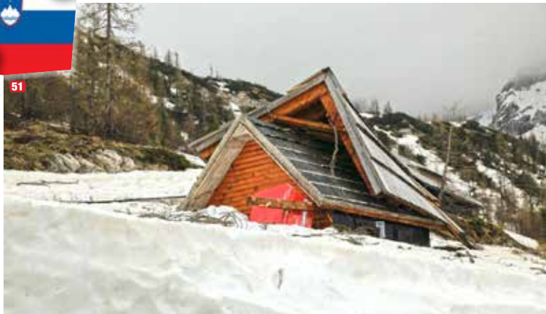
51 Der Souvenirladen auf dem Vršič-Pass wurde schwer beschädigt. (Foto: Romeo Černuta) |
