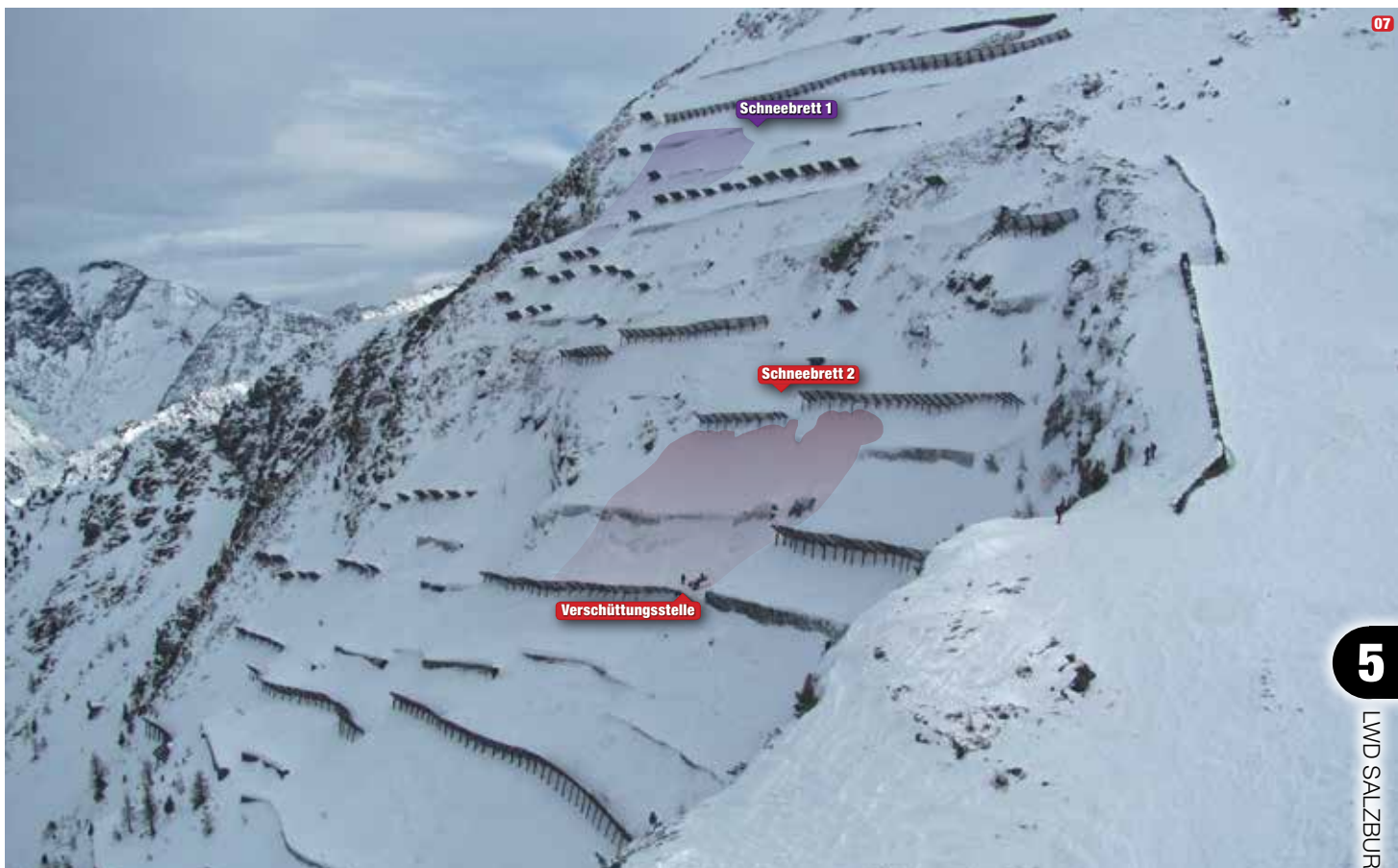
07 Die Stützverbauungen im Nordhang des Thomasecks schützen die Bahnstrecke der ÖBB am Fuss des Berges. Für Wintersportler lauert zwischen ihnen aber Schneebrettgefahr. (Foto: AEG Pongau/BMI, Manfred Schwaiger) |
