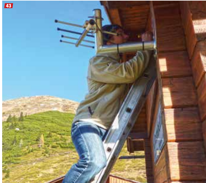
42 Schematische Darstellung der Methodik. (Quelle: LWD Steiermark) | 43 Funkmastmontage für die Radardatenübertragung auf der Planneralm. (Foto: LWD Steiermark) |
