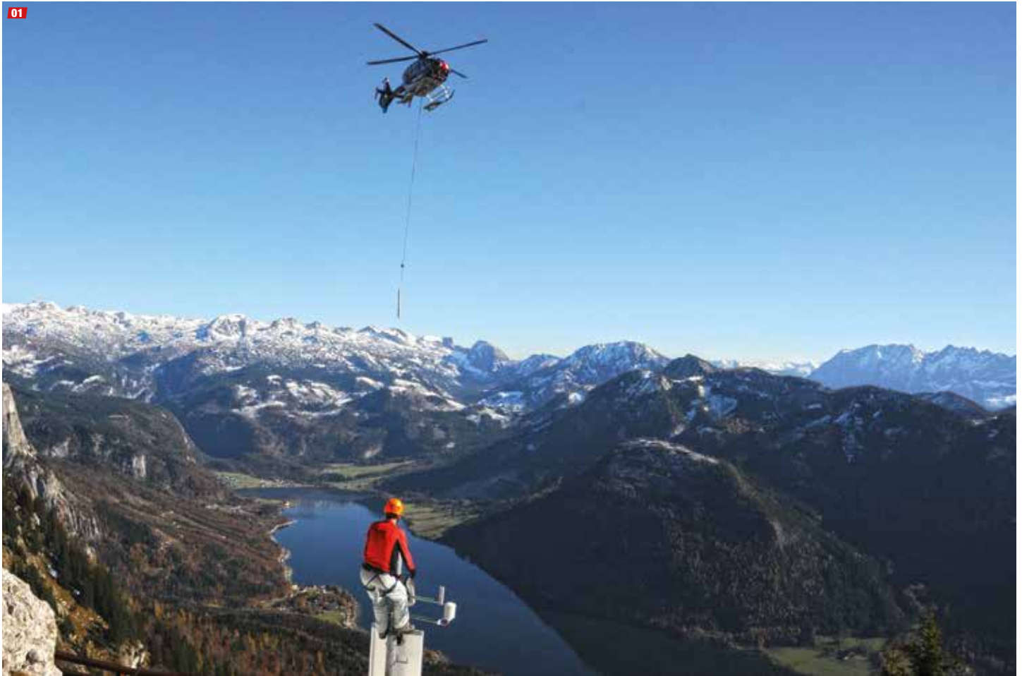
01 Reparaturarbeiten am Schneepegel Ahornkogel mit dem nahezu schneefreien Toten Gebirge im Hintergrund. Die Schneedecke, welche Ende Oktober im Rahmen des ersten Wintereinbruches gerade im Ausseerraum über einen Meter anwuchs, ist nahezu völlig verschwunden. (Foto: LWD Steiermark) |
