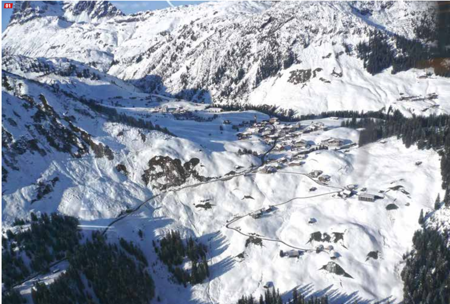
01 Gleitschneerausbrüche gefährden die Landesstraße zwischen Lech und Warth, 24.10.2014. (Foto: LWD Vorarlberg) |
