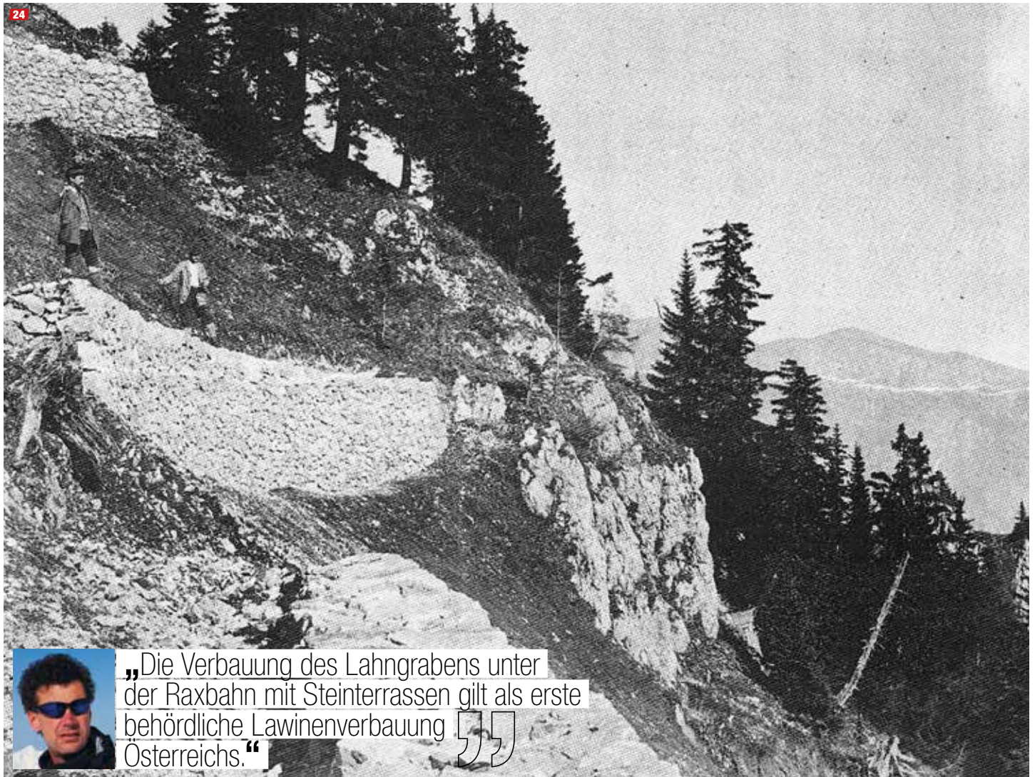
24 Verbauungsdetail im Lahngraben bei Hirschwang 1897/98 (aus dem Buch von W. Kos, 1992: Die Eroberung der Landschaft, Semmering – Rax – Schneeberg). (Quelle: W. Kos) |
