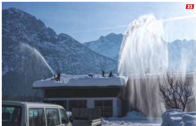
23 In Leisach wurde ein Dach mit Schneefräsen und Schaufeln von den Schneelasten befreit. (Foto: ZAMG, 19.02.2021) |
